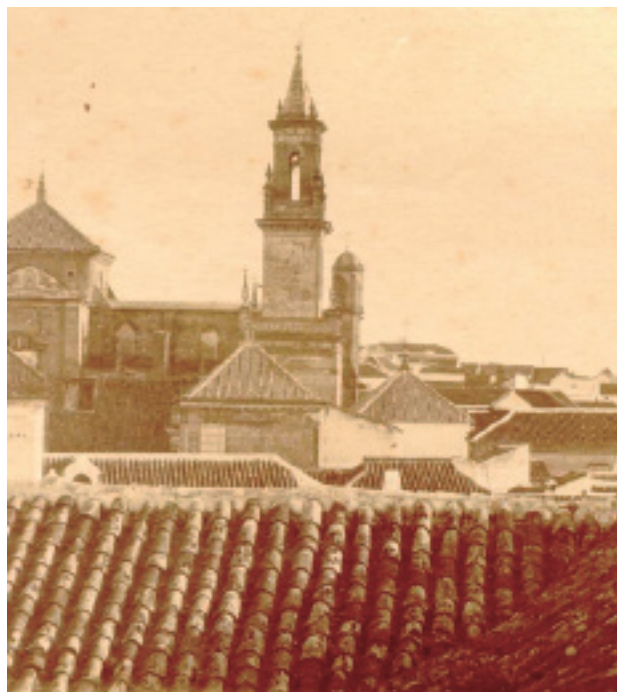
Exterior de la iglesia de Santa María con su antigua torre.
