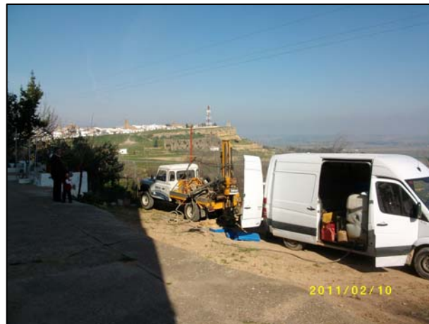
Detalles de la ejecución del sondeo a rotación
