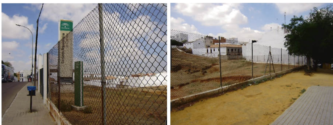
DIVERSAS IMÁGENES DEL CERRAMIENTO ACTUAL DEL ANFITEATRO
