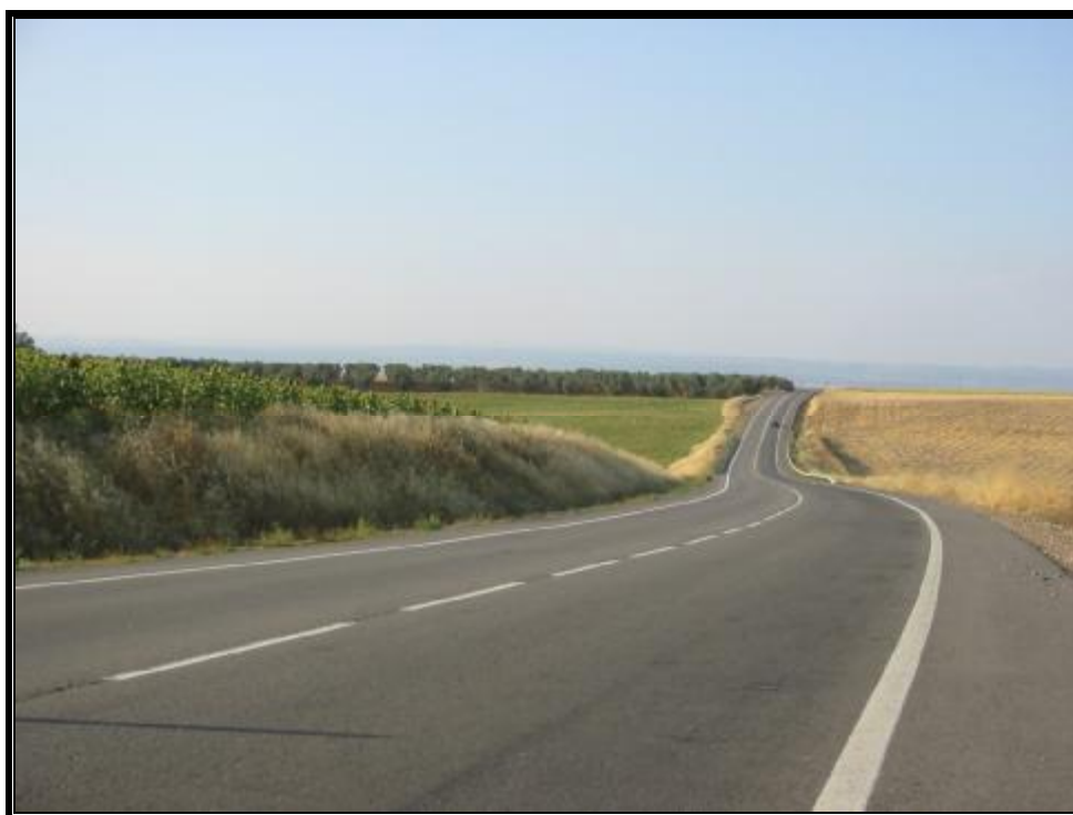
Foto 42.-Buen estado de la carretera de Lora (A-457).
