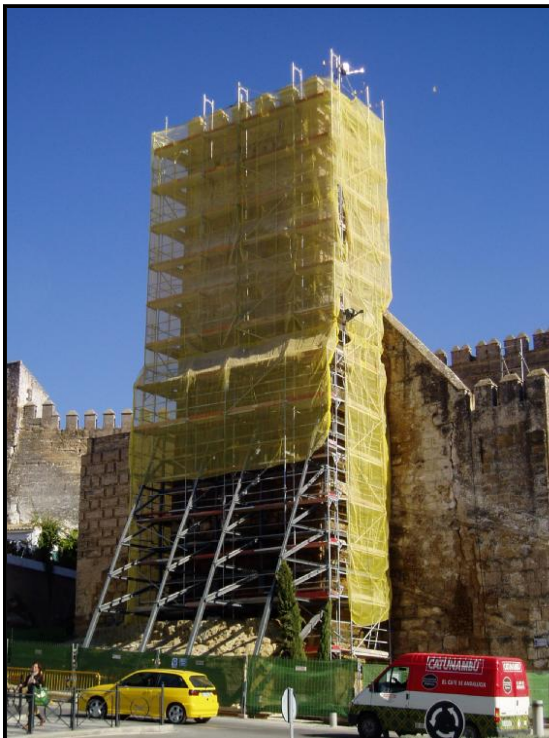
Foto 65.-Restauración de la Torre del Homenaje del Alcázar de la Puerta de Sevilla.
