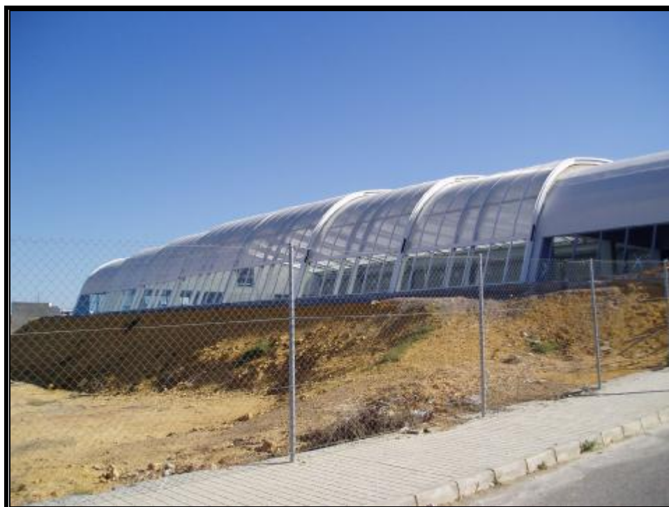
Foto 66.-Construcción de la piscina municipal cubierta.
