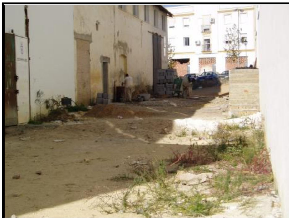
Foto 64.-Obras de mejora en edificios municipales.
