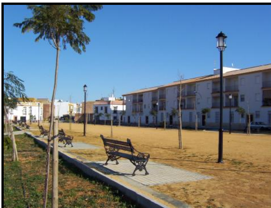
Foto 46.-Alameda en construcción.
