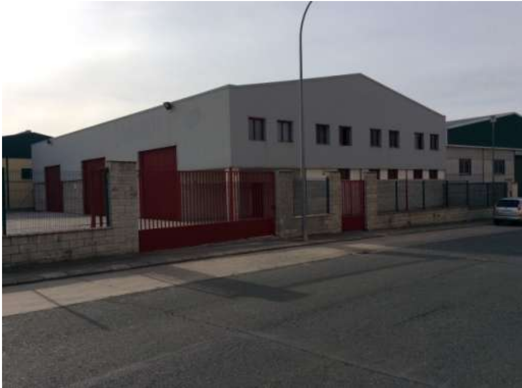
Vista exterior de la edificación existente
