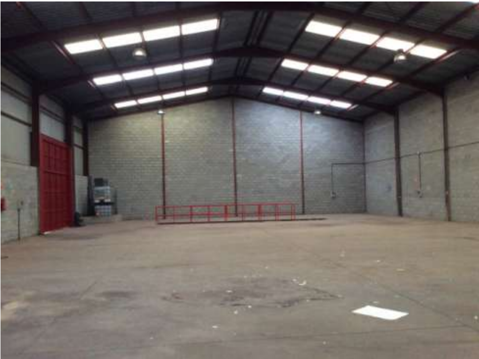
Vista interior de la edificación existente
