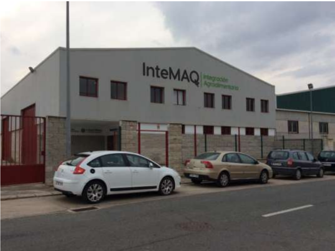
Vista fachada de la parcela y nave
