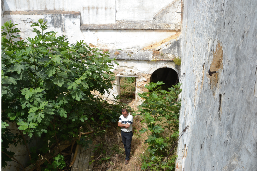
3. Vista interior desde escalera del patio
