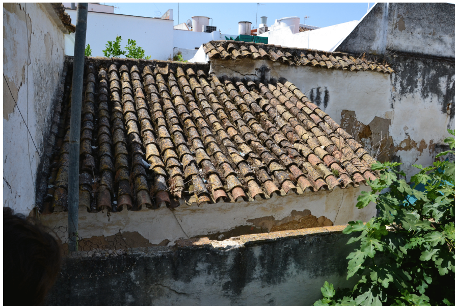
4. Vista de almacén de fondo desde escalera del patio
