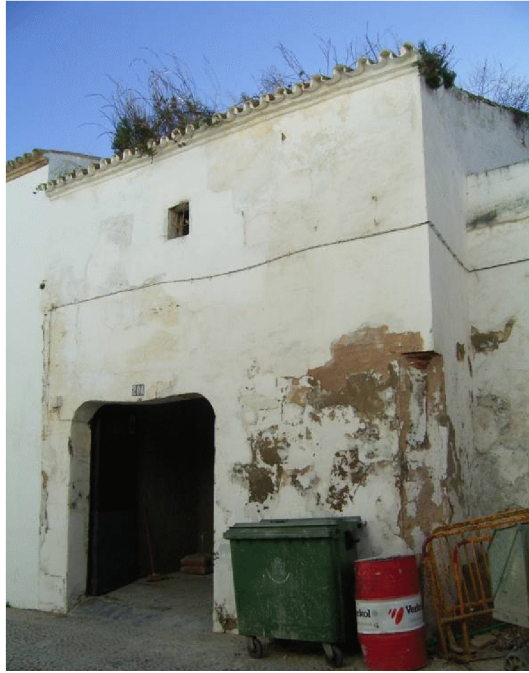
1. Fachada de la edificación antes de las obras autorizadas. Año 2005. Fuente: Plan Especial del Conjunto Histórico.
