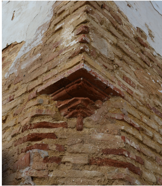
3. Detalle de esquina achaflanada de fachada durante las obras. Año 2014. Fuente: Departamento de Arqueología Municipal.
