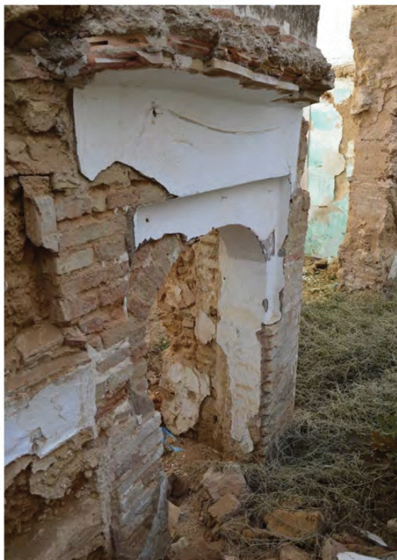
Arco enmarcado en alfiz en muro interior de crujía de fachada
