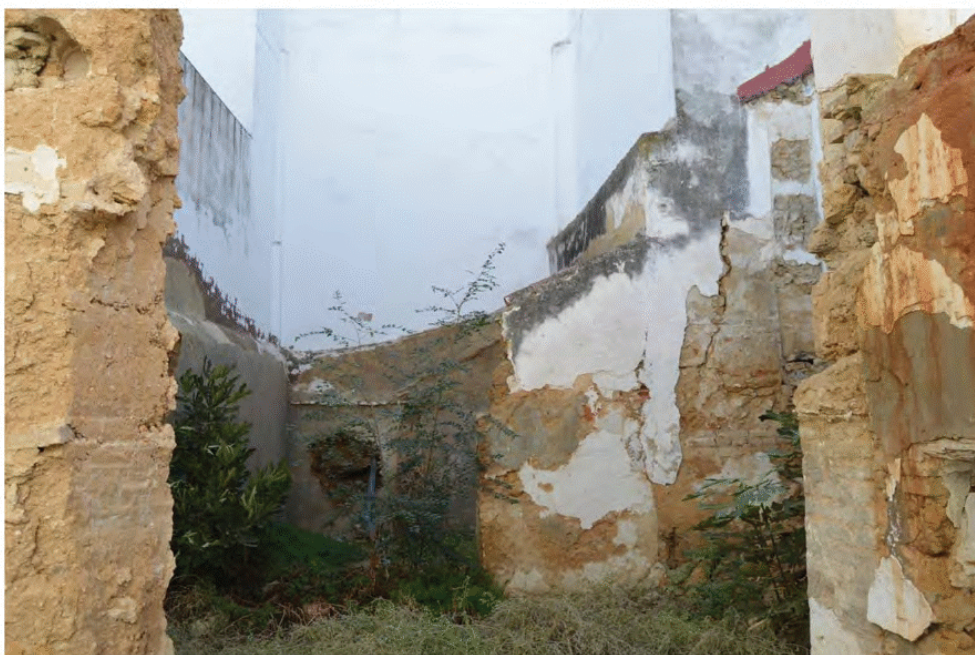
Vista del fondo de la edificación
