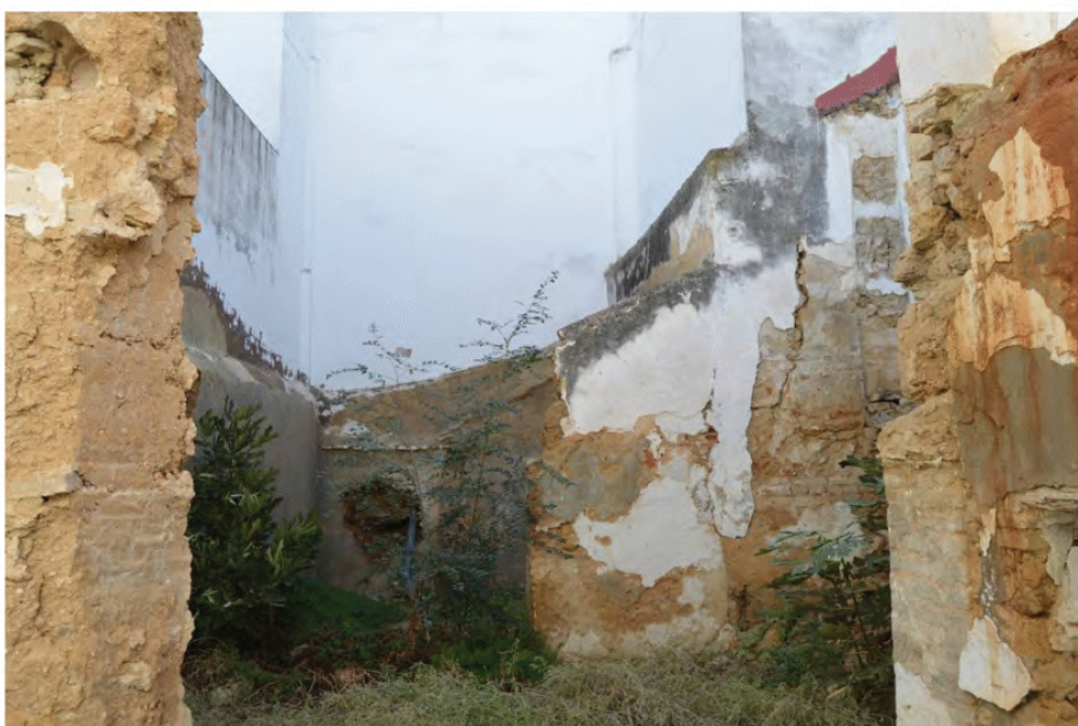
Vista del fondo de la edificación
