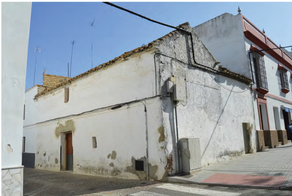
Fachada de inmueble Chamorro, 25, esquina con Ronda del León de San Francisco
