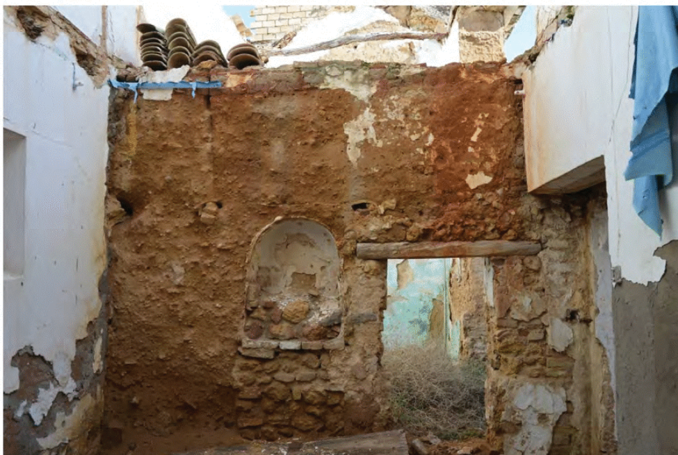
Vista desde del interior de la crujía de fachada
