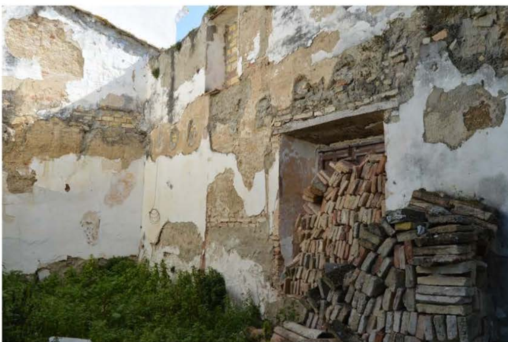
Vista interior del muro de fachada
