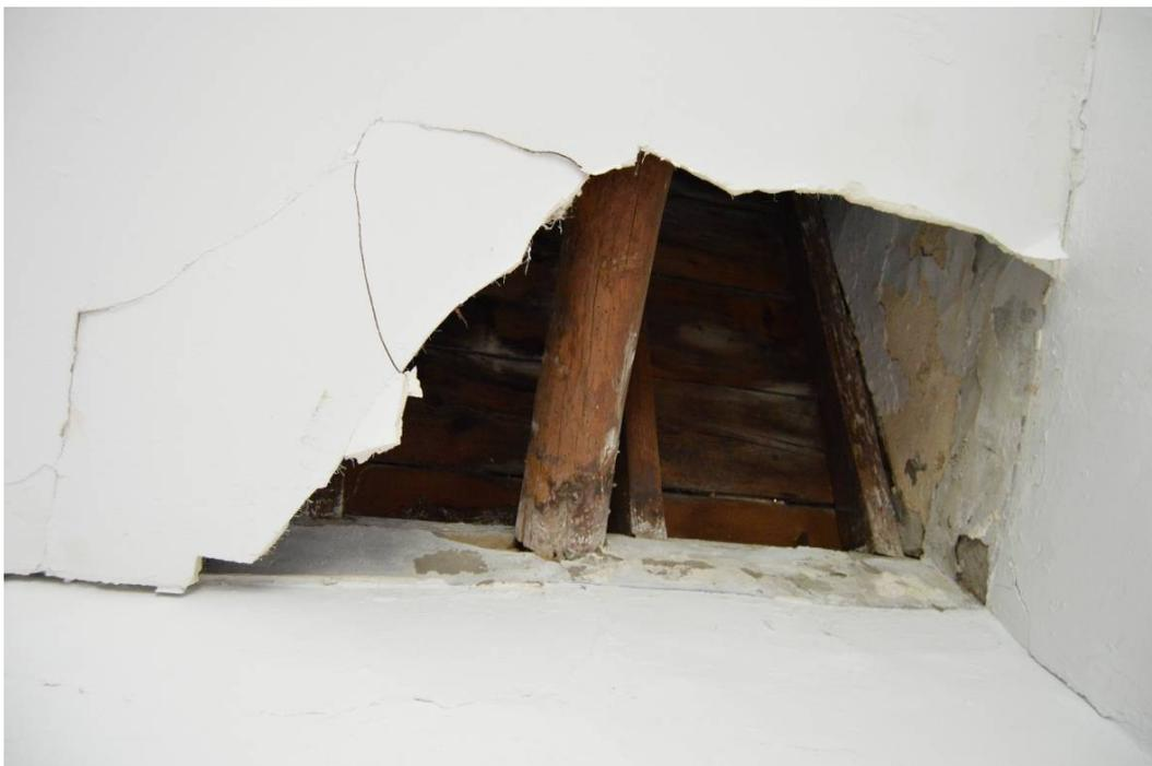
Tirante del entramado de madera de cubierta de primera cruja de par y nudillo
