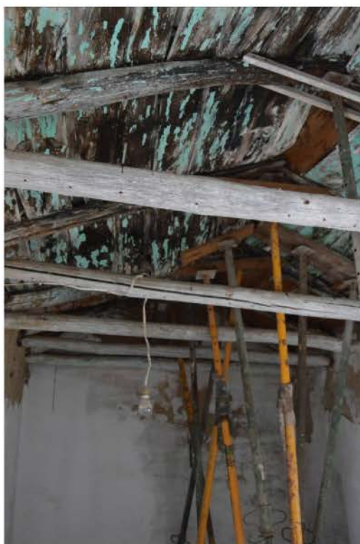
Cubierta de par y nudillo apuntalada
