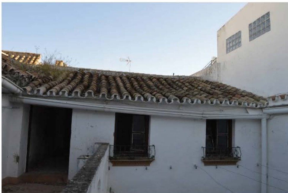
Vista de crujía de fondo de patio desde terraza de planta primera
