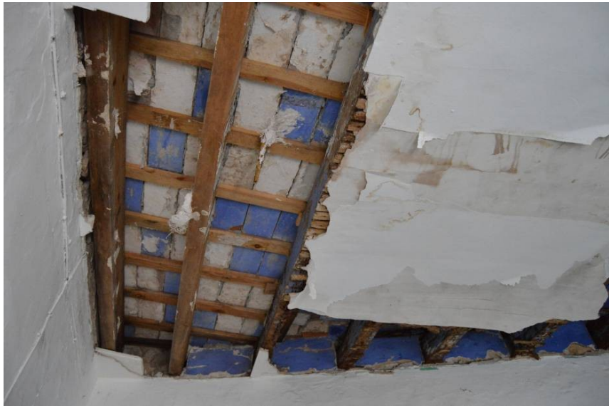
Forjado de viguetas de madera de planta primera
