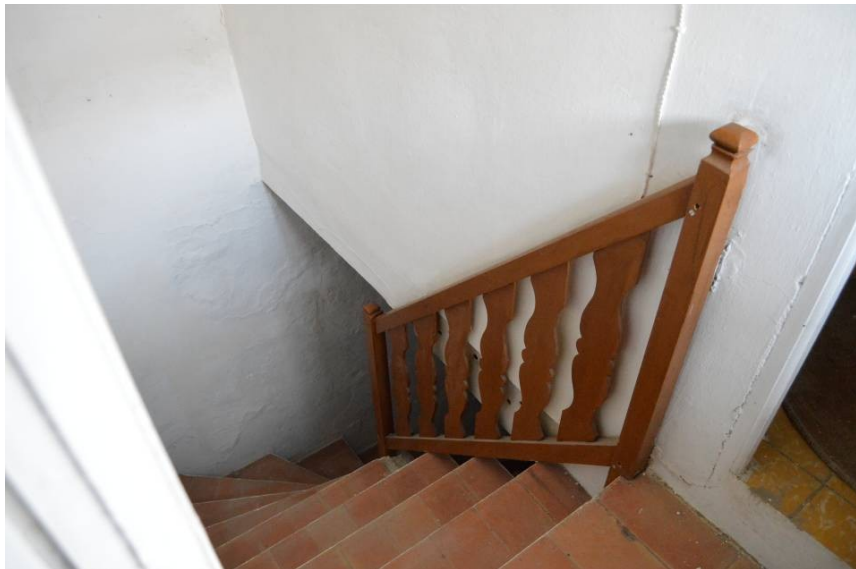
Escalera interior en crujía de fondo
