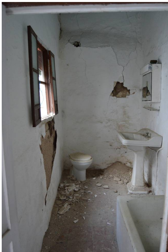
Aseo, junto a patio de fachada
