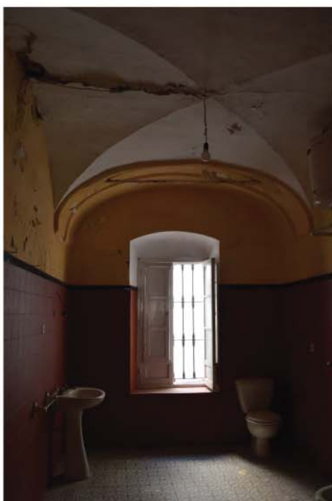
Planta primera. Vista de bóvedas de galería del patio y baño
