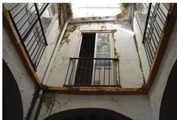
Planta baja. Vista del patio central
