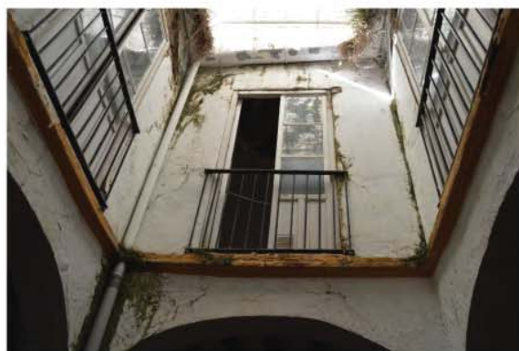
Planta baja. Vista del patio central
