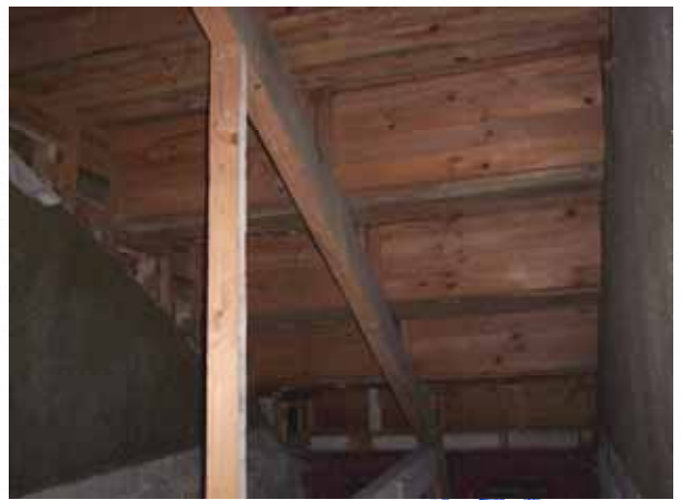
VISTA INFERIOR. VIGA Y MONTANTE DE MADERA
