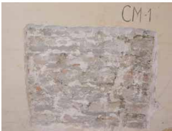
MURO DE FABRICA DE LADRILLO MACIZO
