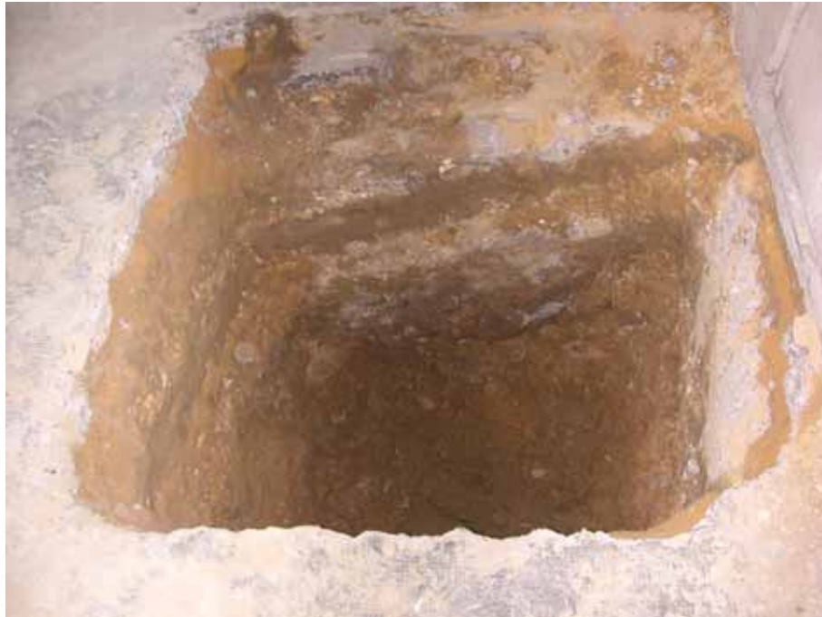
CIMENTACIÓN DE MURO DE FACHADA LATERAL DERECHA EJECUTADA CON UNA ZANJA CORRIDA DE HORMIGÓN EN MASA
