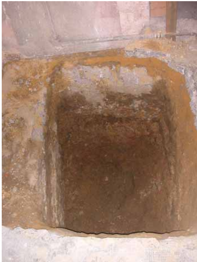
CIMENTACION DE MURO PERPENDICULAR A FACHADA LATERAL DERECHA EJECUTADA CON UNA ZANJA CORRIDA DE HORMIGÓN EN MASA
