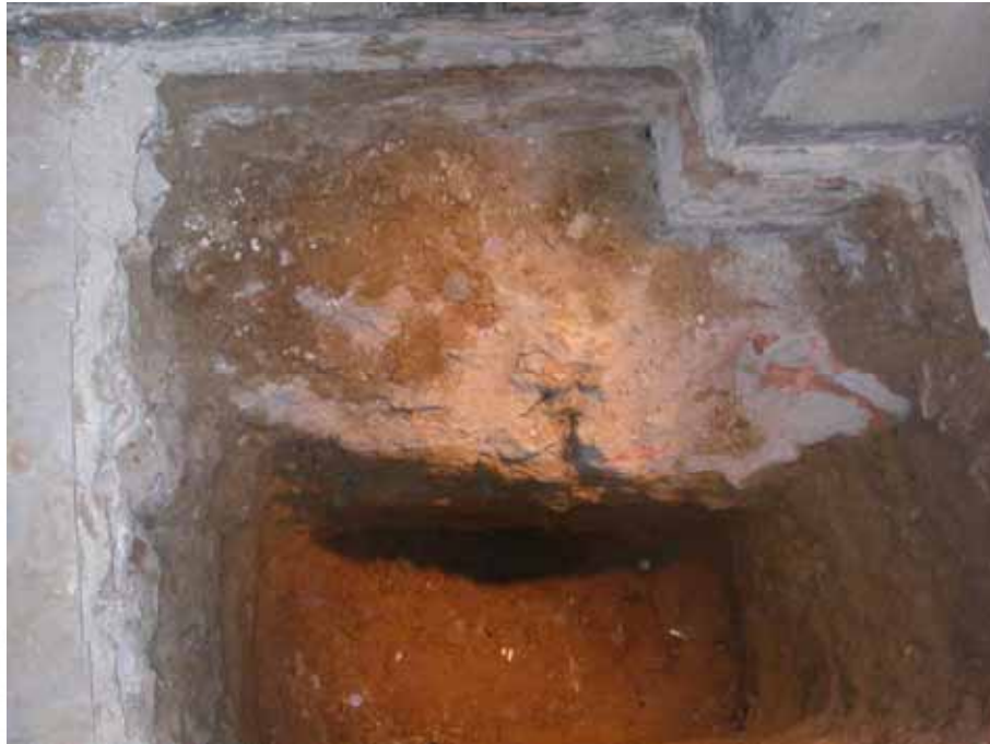
SE OBSERVA LA FABRICA DE LADRILLO MACIZO Y LA CIMENTACIÓN CONSTITUIDA POR UNA ZANJA CORRIDA DE HORMIGÓN EN MASA
