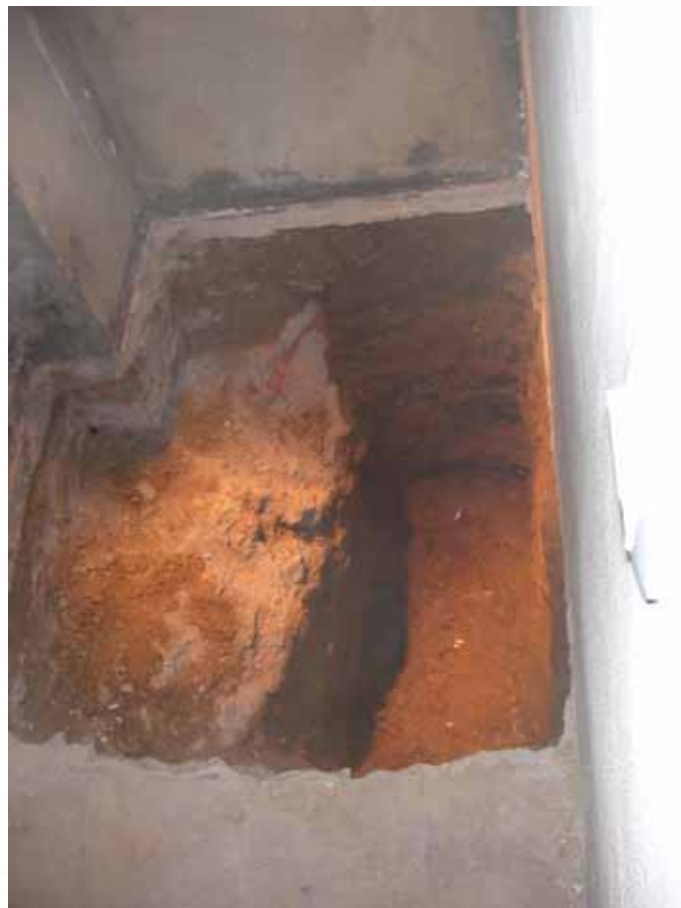
SE OBSERVA LA FABRICA DE LADRILLO MACIZO Y LA CIMENTACIÓN CONSTITUIDA POR UNA ZANJA CORRIDA DE HORMIGÓN EN MASA
