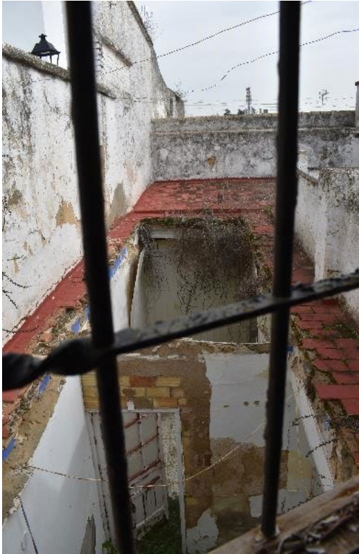
Forjados de vigería de hormigón colapsados.
