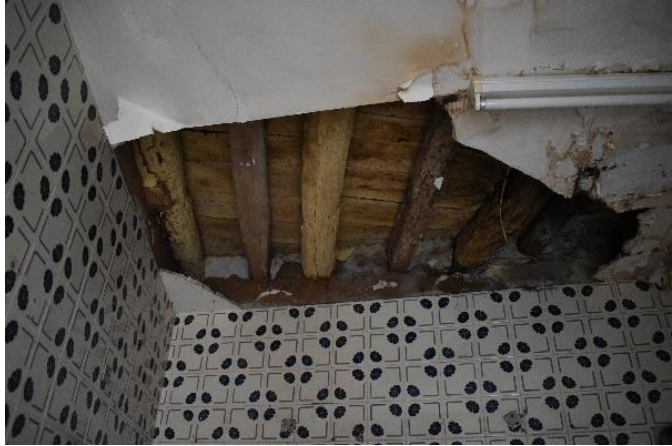
Entresuelo de rollizo de madera y entablado.
